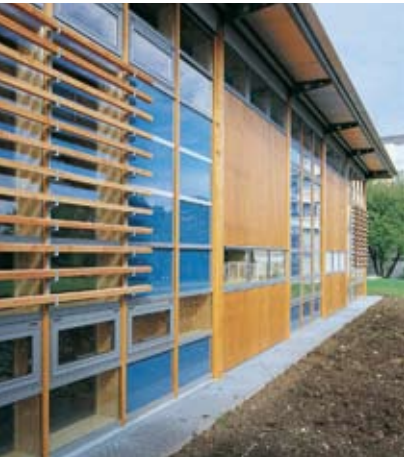
Onderwijsinstelling in Albstadt, Architect Prof. Schempp, Tübingen, Duitsland
